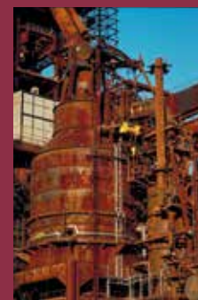
Usine sidérurgique Solmer, équipement anti-pollution : traitement primaire des gaz sur le haut fourneau 1, photographie de Jacques Windenberger, 72Fi 38/35 © Conseil Général 13 - Archives Départementales.
