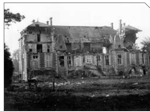
Château de Sorel à Orvillers-Sorel (Oise) appartenant à François de Bardou de Segonzac en 1922. AJ/28/530, dossier 2647 B. © Arch. nat./pôle image
