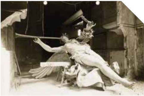
Exposition internationale de Paris, 1937, photographie de Baranger, « La démolition du Trocadéro », statue de La Renommée. F/12/12114. © Arch. nat./pôle image
