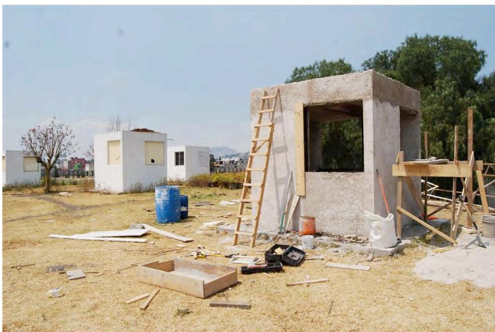
Figura 4. Módulo de TVC con muros de 15cm de espesor, Zacatenco, Ciudad de México.
